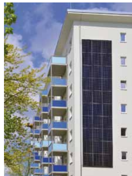
Abb. 2: Ein weiterer Pionier beim Einsatz von PVT-WP-Systemen ist die Berliner degewo AG. Die Anlage ist Teil des Sanierungskonzeptes für ein Mehrfamilienhaus in Berlin-Lankwitz. 1954 erbaut, umfasst das Gebäude insgesamt 64 Wohneinheiten über acht Stockwerke mit einer Gesamtwohnfläche von 3.733 m 2 .
